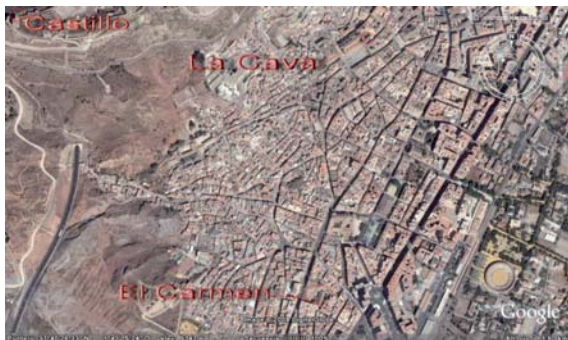
Figura I. Localización del área objeto de estudio en el casco urbano, en relación con la ubicación del Castillo, y la localización del trazado de la muralla islámica y parte del alzado de la iglesia de San Jorge en la calle Cava, número 1 y 3 1 .
