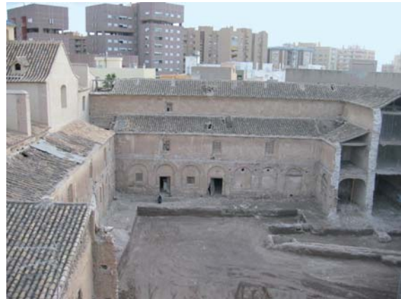
Lámina 2. Panorámica de las dependencias conventuales adosadas a la Iglesia. Foto: Rubén Sánchez Gallego.
